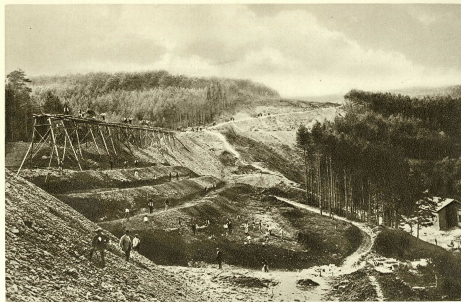
Dammschüttung an der Strecke Weimar—Gera um 1875 Zeitgenössische Aufnahme
